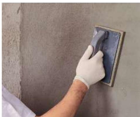
Konečná úprava Planitop 540 použitím hubky
