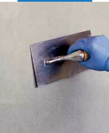
Vyhladzovanie Planitop 560 hladkou kovovou stierkou
