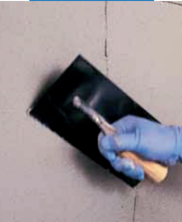
Aplikácia Planitop 560 hladkou kovovou stierkou
