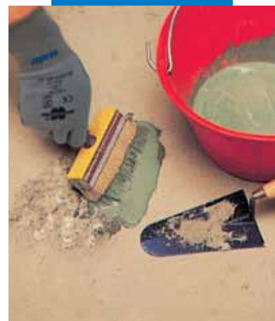
Lokálna oprava podlahy. Aplikácia adhézneho mostíka
