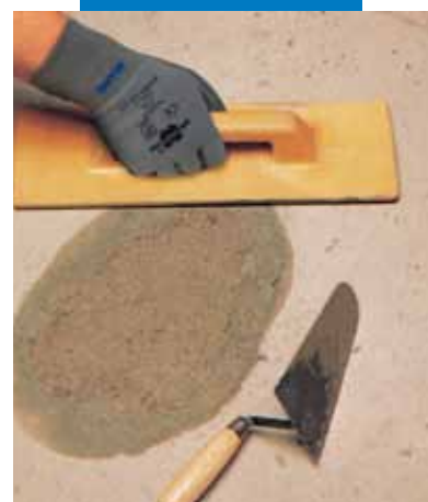
Lokálna oprava podlahy. Konečné vyhladenie
