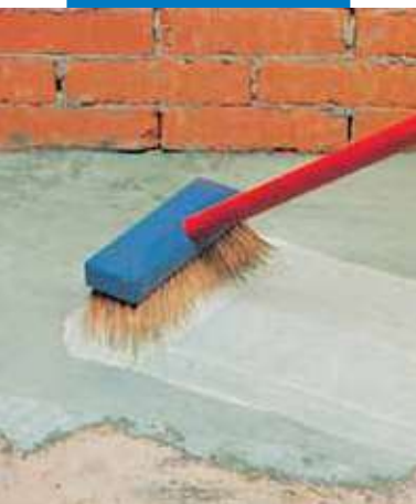
Aplikácia cementového adhézneho mostíka s prísadou Planicrete
