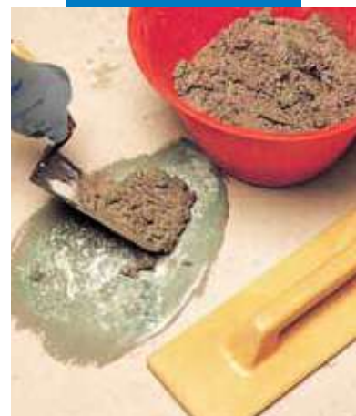
Lokálna oprava podlahy. Aplikácia vyrovnávacej malty
