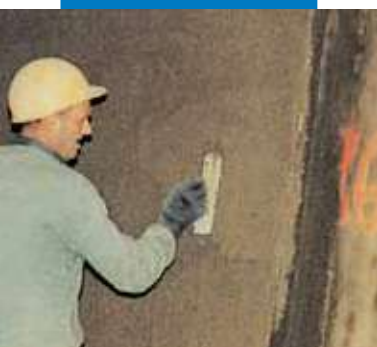
Cementová ometka s prísadou Planicrete - Diaľničný tunel Vile Marie - Montreal (Kanada)
