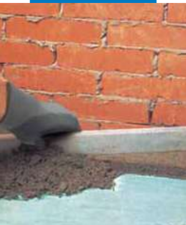
Aplikácia kotveného cementového poteru s prísadou Planicrete
