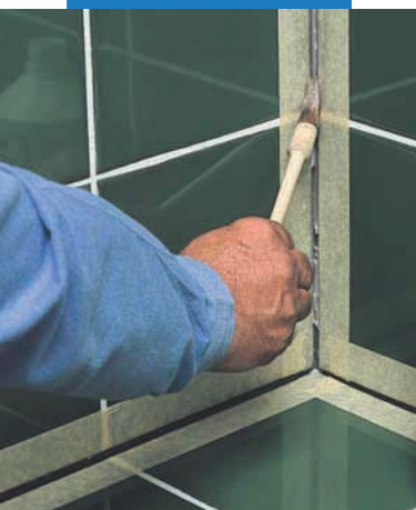
Nanášanie penetračného náteru Primer FD.
