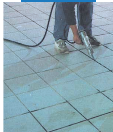
Tesnenie škár v keramickej dlažbe tmelom Mapesil AC.
