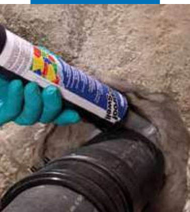
Aplikácia Mapeproof Swell okolo potrubia
