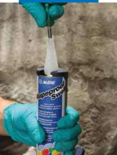
Vyhotovenie otvoru do ochrannej membrány v špiči
