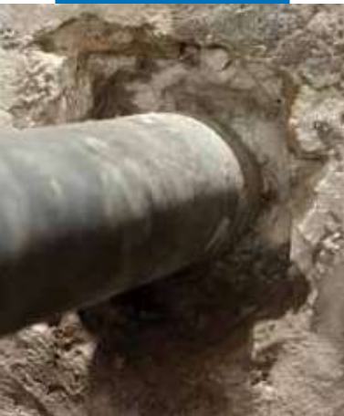
Mechanické príprava priestoru okolo potrubia
