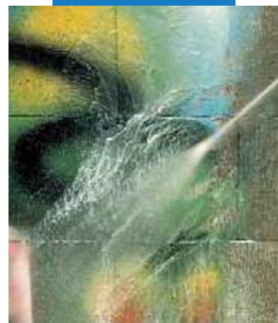
Čistenie vysokotlakovým vodným lúčom
