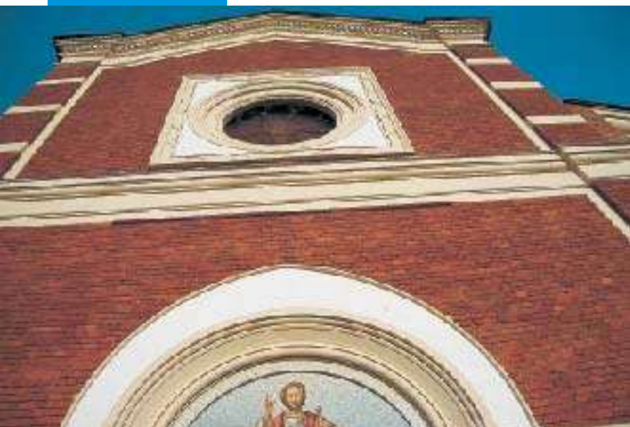
2. Lícové cihly ošetřené Antipluviolem S
