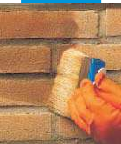
1. Nanášení Antipluviolu S štětkou
