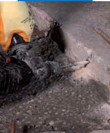
Vítanie otvorov na osadenie výstužnej ocele (napojenie)
