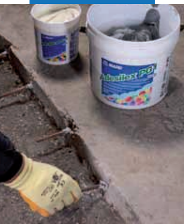
Kotvenie napájacej výstužnej ocele použitím lepidla Adesilex PG1
