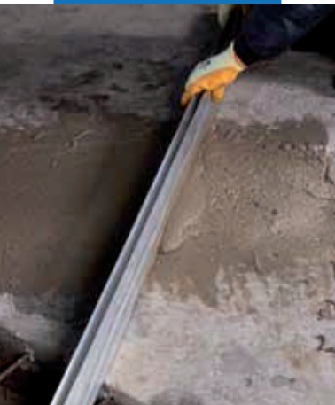
Vyhľadzovanie malty Mapegrout SV Fiber
