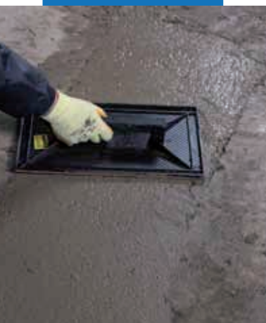
Ošetrovanie povrchu Mapegrout SV Fiber
