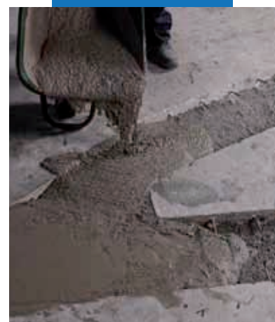
Nanesenie malty Mapegrout SV Fiber na opravované miesta
