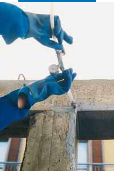
Stĺp opláštený s Adesilex PG1
