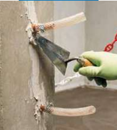
Upevnenie injektážnych trubic
