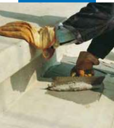
Aplikácia Adesilex PG1 zubovou stierkou pre konštrukčné lepenie prefabrikovaných schodov
