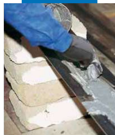
Aplikácia Adesilex PG1 na kovovej platni
