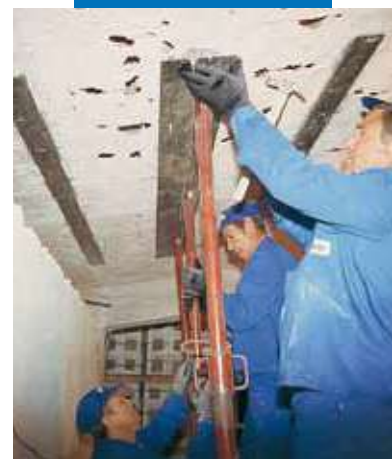
Inštalácia kovovej platne pre zosilnenie konštrukcie
