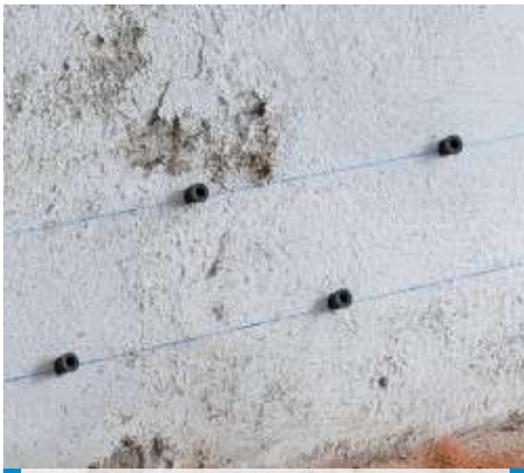
Detail osadených injektátorov
