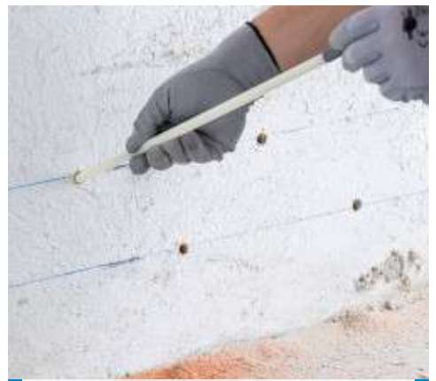
Vloženie injektátorov do otvorov
