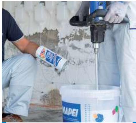
Príprava injektážnej zmesi
