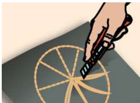
Obr.1 - Narezanie prvého kusu Mapethene HT AP podľa priemeru prvku prechádzajúceho cez konštrukciu
