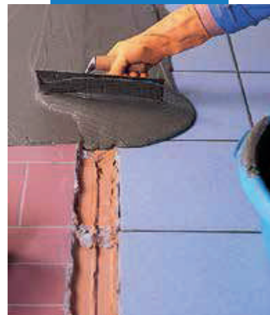
Vyrovnanie stávajúcej podlahy s Adesilex P4
