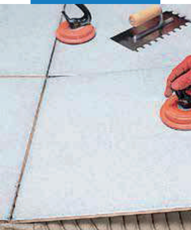
Inštalácia veľkoformátovej dlažby
