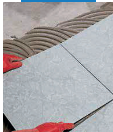
Inštalácia porcelánovej dlažby
