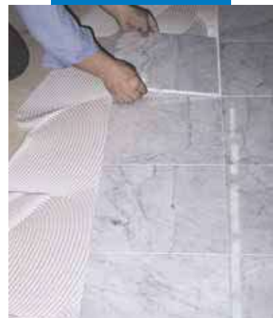
Inštalácia mramorového kameňa Carrara na drevený podklad použitím bieleho lepidla Keralastic
