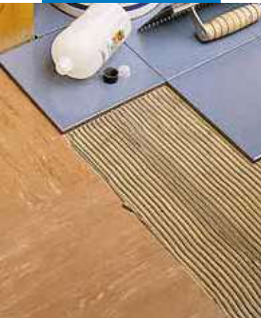
Inštalácia dlažby na starú podlahovú krytinu z PVC
