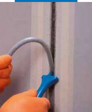
Vloženie polyetylénového povrazca Mapecfoam za účelom vydimenzovania hĺbky škáry
