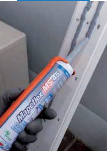
Lepenie plastového profilu v exteriéri
