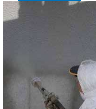
Mapelastic nanášaný nástrekom na viadukte
