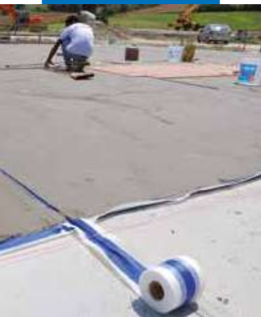
Mapelastic použitý pri izolovaní cementového poteru s páskou Mapeband
