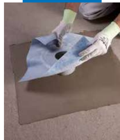
Aplikácia vpuste Drain Vertical na Mapelastic
