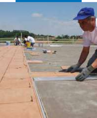
Lepenie dlažby lepidlom Kerabond + Isolastic
