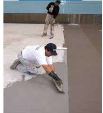
Mapelastic použitý pri izolovaní plaveckého bazéna
