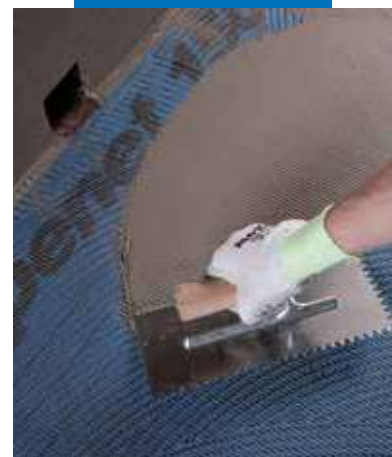
Mapelastic nanášaný na sklotextilnú mriežku Mapenet 150
