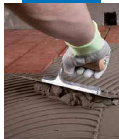
Nanášanie lepidla Granirapid na terasu, podklad zaizolovaný s Mapelastic
