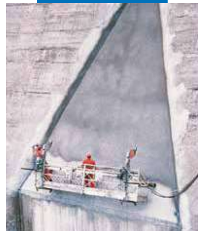
Mapelastic nanášaný nástrekom na vodnej priehrade
