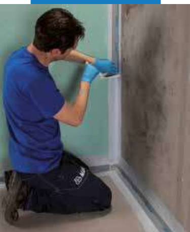
Inštalácia veľkoformátovej dlažby
