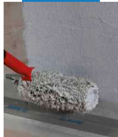
Inštalácia veľkoformátovej dlažby
