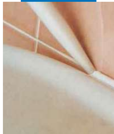
Tesnenie škár v styku so sanitárnym zariadením
