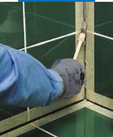
Nanášanie penetračného náteru Primer FD
