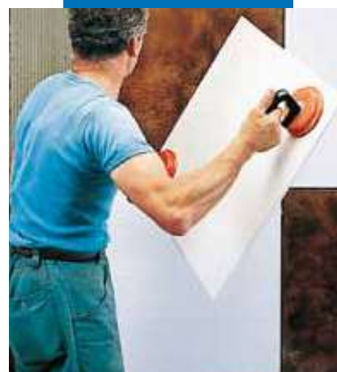
Inštalácia KERAION na stenu
