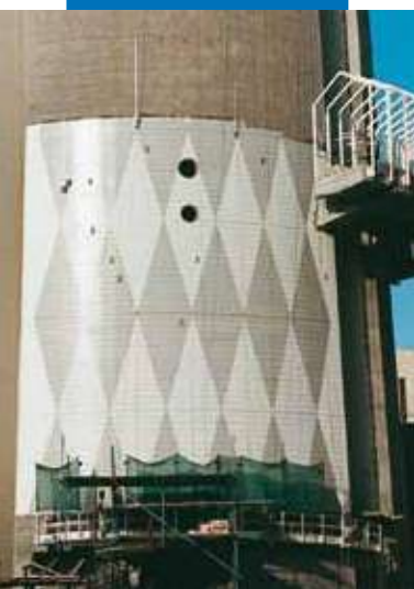
Príklad inštalácie obkladových prvkov Klinker na betón použitím Kerabond + Isolastic - Telekomunikačná veža, Kuvajť City, Kuvajť
