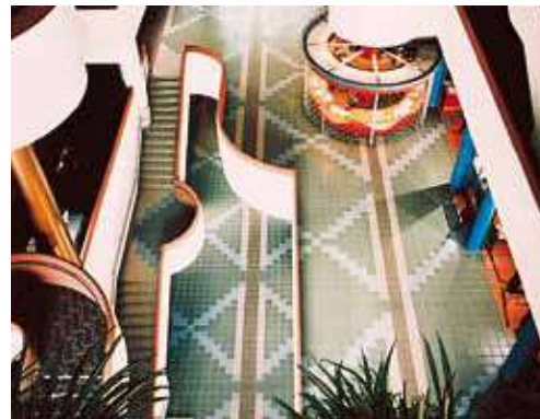
Inštalácia porcelánových obkladových prvkov použitím Kerabond T + Isolastic - Civic Centre, North York Ontario, Kanada
