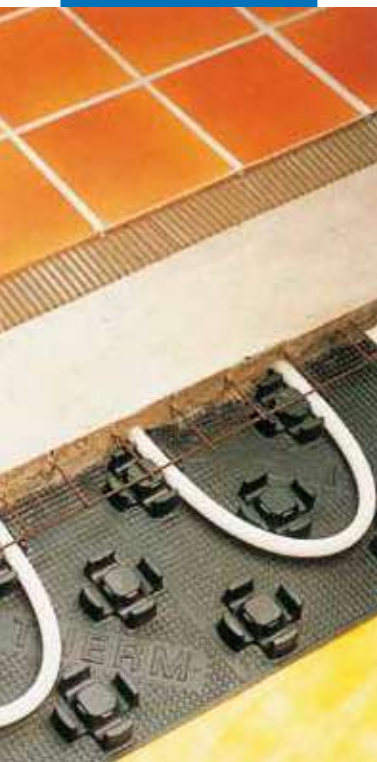
Inštalácia obkladových prvkov na vykurovanej podlahe
