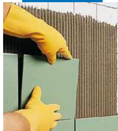
Inštalácia obkladu na pôvodný obklad
