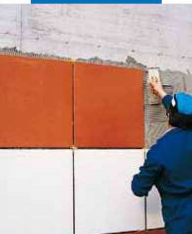
Inštalácia obkladových prvkov veľkého formátu s použitím Kerabond T + Isolastic
