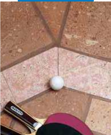
Dlažba Cotto leštená na mieste a vyškárovaná použitím škárovacej malty Keracolor GG zmiešanej s tekutou prísadou Fugolastic
