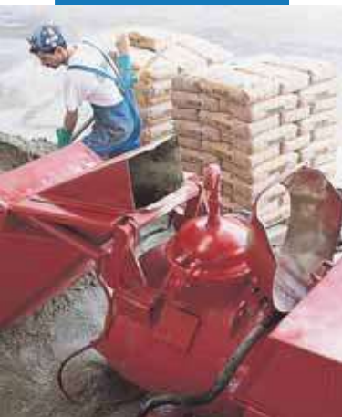
Miešanie poteru Topcem pomocou automatického čerpadla.
