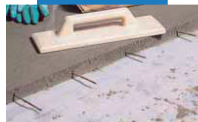
Detail zapracovania výstužnej ocele pri napájaní poteru Topcem
