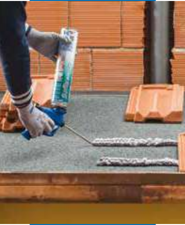
Lepenie strešnej krytiny na pásy
