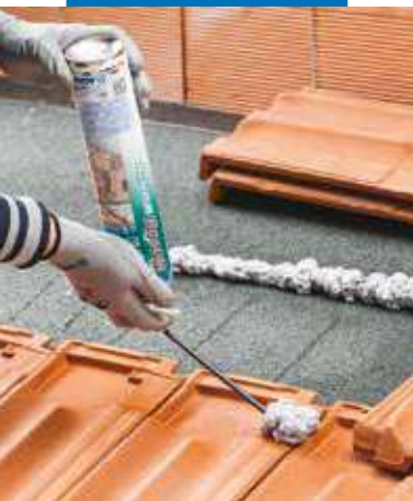
Lepenie strešnej krytiny na pásy
