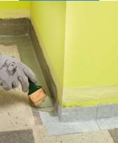
Aplikácia Mapeband SA na poter
