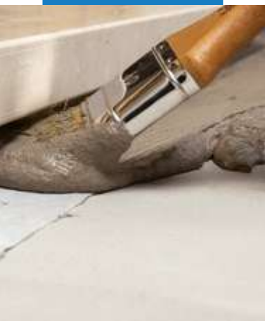
Príklad aplikácie Mapeband SA v ťažko prístupnom mieste pod dverným prahom
