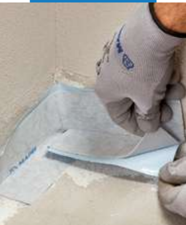
Aplikácia Mapeband SA v kúte
