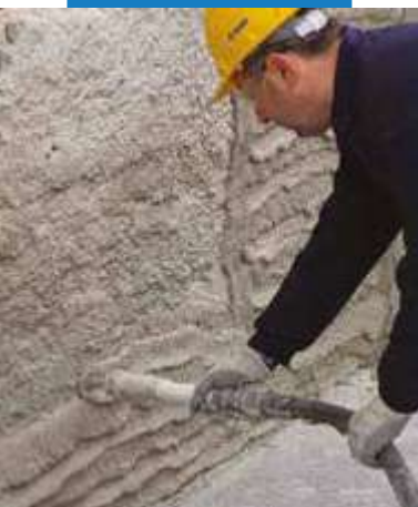
Aplikácia Poromap Deumidificante omietacím zariadením
