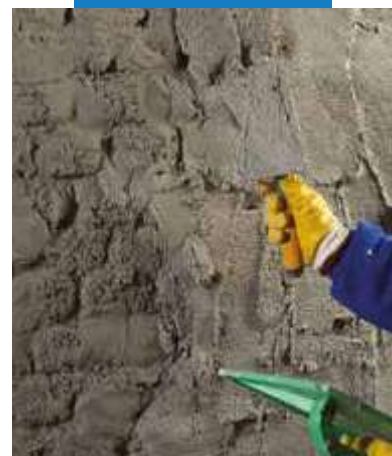
Aplikácia Poromap Deumidificante s použitím stierky
