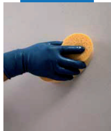
Dokončenie povrchu Mape-Antique FC Civil navlhčenou hubkou
