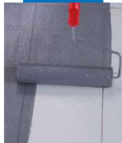
Aplikácia Eco Prim Grip valčekom na pôvodné obkladové prvky z porcelánu
