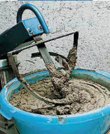
Príprava malty malým miešacím zariadením
