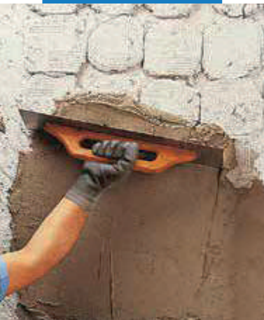
Vyrovnávanie povrchu steny oceľovým hladidlom
