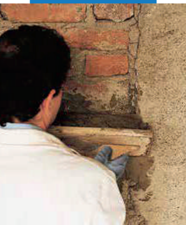
Oprava starého tehlového muriva
