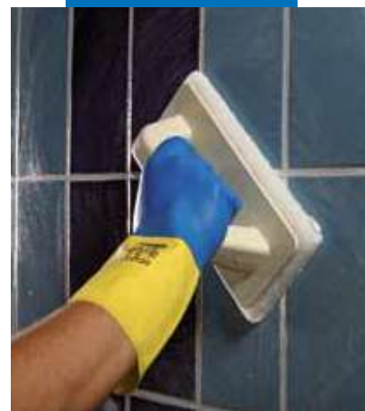
Emulgácia Kerapoxy CQ vodou použitím nástavca Scotch-Brite®
