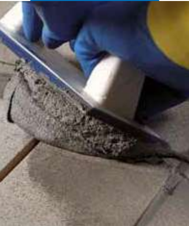
Nanesenie Kerapoxy CQ pomocou stierky MAPEI
