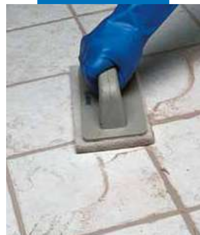
Konečné dočistenie so špongiou Scotch-Brite®
