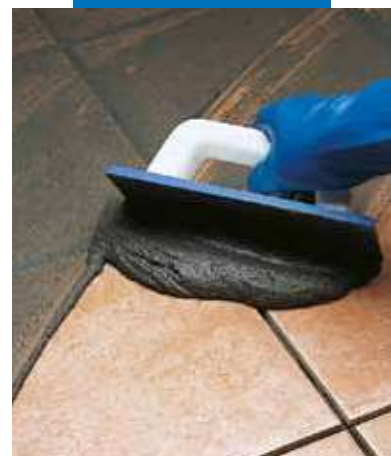
Škárovanie jeden krát vypaľovanej dlažby s gumovou stierkou
