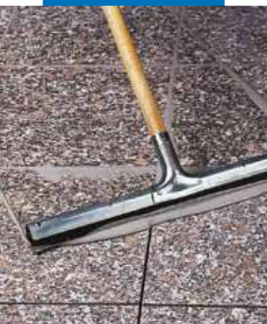
Škárovanie leštenej žuly špeciálnym, gumovým, podlahárskym náradím
