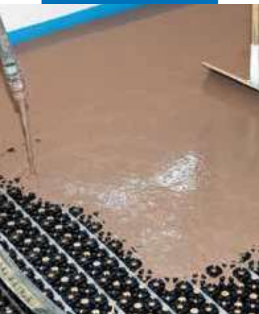
Čerpanie a vyhladenie zmesi Novoplan Maxi
