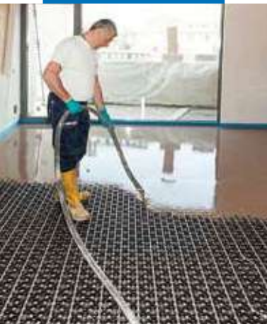
Vrstva zmesi Novoplan Maxi nanášaná na kompaktný podlahový vykurovací systém
