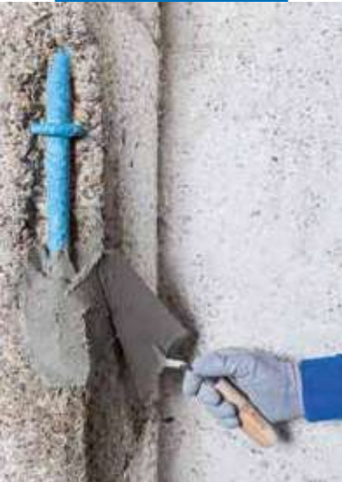
Aplikace Planitopu Rasa & Ripara R4 zednickou lžící
