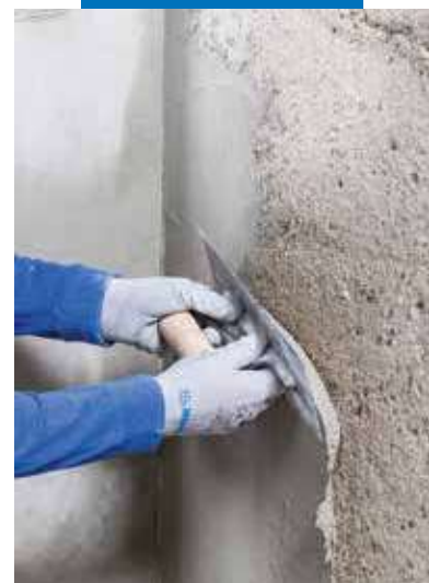
Aplikace Planitopu Rasa & Ripara R4 hladítkem
