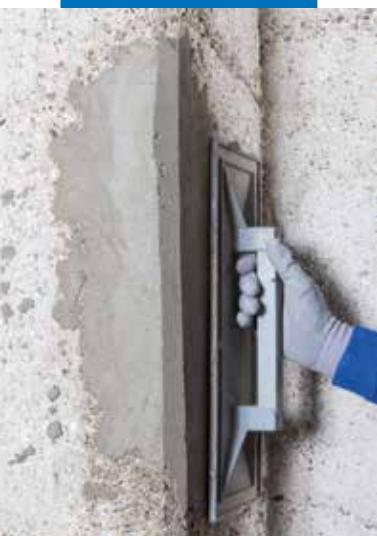
Vyhlazení povrchu Planitopu Rasa & Ripara R4 hladítkem
