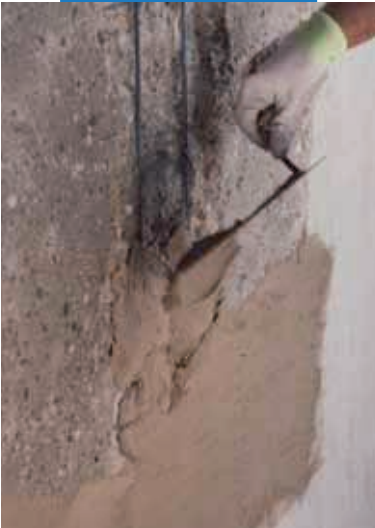
Aplikácia malty Planitop Rasa & Ripara murárskou lyžicou
