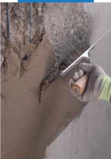
Aplikácia malty Planitop Rasa & Ripara stierkou
