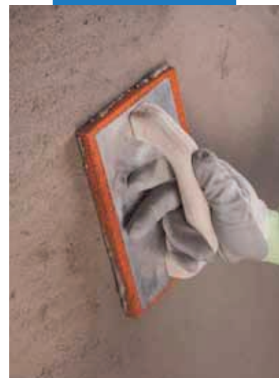
Konečné dokončenie povrchu hubkovým hladidlom
