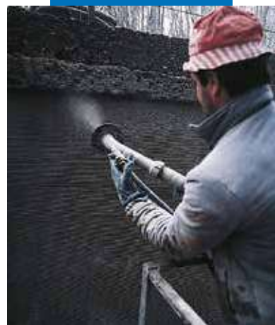
Vodná elektráreň Bertini - Robbiate (Como) - Taliansko: aplikácia nástrekom
