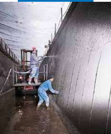
Vodná elektráreň Bertini - Robbiate (Como) - Taliansko: aplikácia stierok
