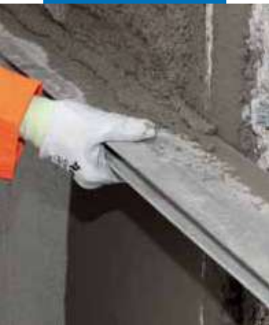
Vyrovnanie opravnej malty Mapegrout 430 latou
