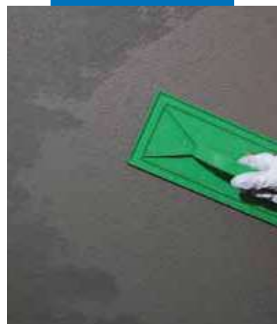
Konečné vyhladzovanie opravnej malty Mapegrout 430
