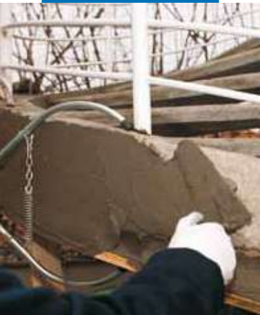
Aplikácia Mapegrout 430 murárskou lyžicou
