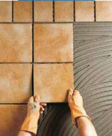
Inštalácia Klinker obkladových prvkov v eteriéri
