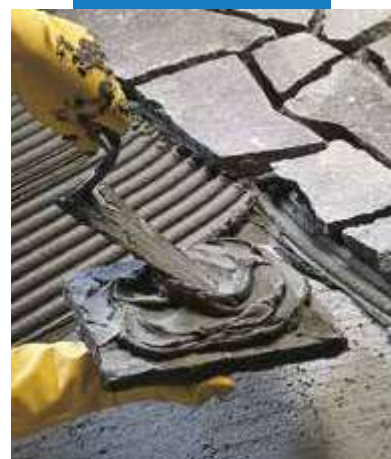
Inštalácia kameňa metódou obojstranného lepenia
