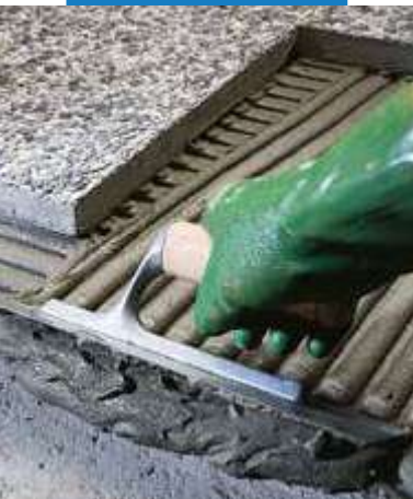
Inštalácia dlažby na terase
