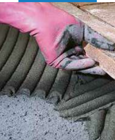
Inštalácia Teracotta obkladových prvkov na nerovnom podklade
