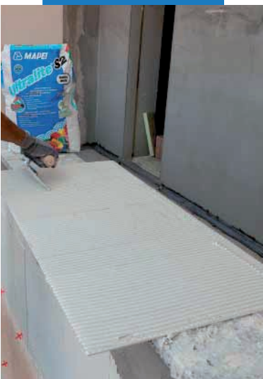
Nanosenie lepidla na zadnú stranu obkladového prvku
