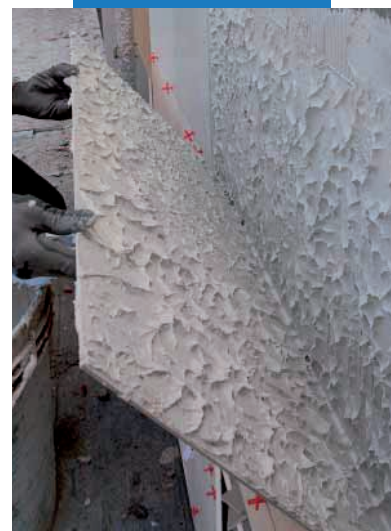
Kontrola úplného pokrytia zadnej strany obkladového prvku lepidlom pri inštalácii na vonkajšej fasáde
