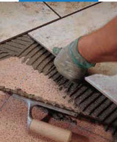
Inštalácia jeden krát vypalovaných obkladových prvkov na podlahe z terrazzo v exteriéri
