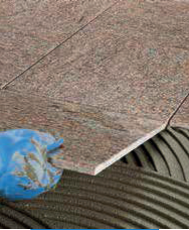
Inštalácia mramoru na podlahe
