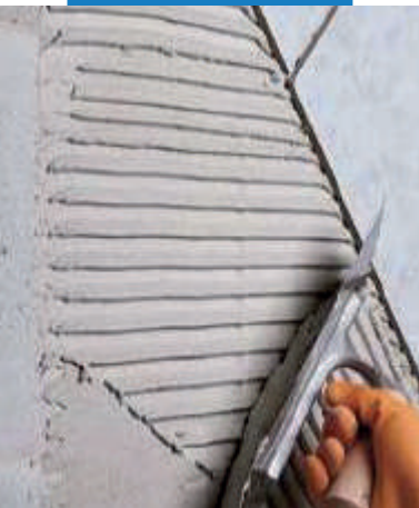
Inštalácia jeden krát vypalovaných keramických obkladov na stenu z pórbetónových tvárnic
