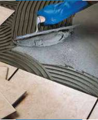
Inštalácia jeden krát vypaľovaných obkladových prvkov
