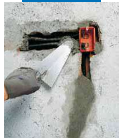
Lampocem použitý upevňovaní puzdra a elektrických káblov
