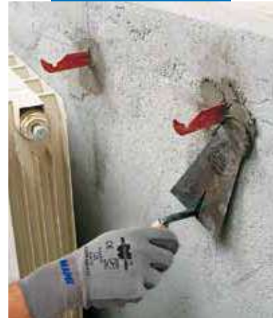
Lampocem použitý pri osadzovaní radiátora
