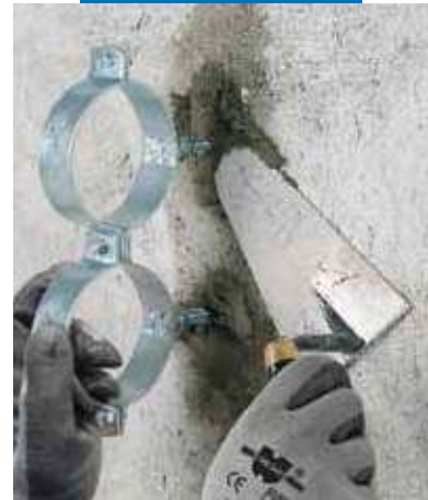
Lampocem použitý pri osadzovaní konzol pre rúry
