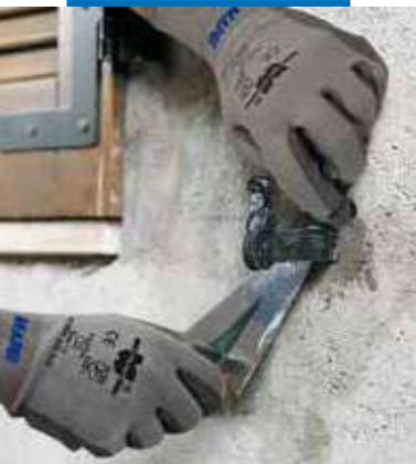
Lampocem použitý pri osadzovaní okenného kotviaceho prvku
