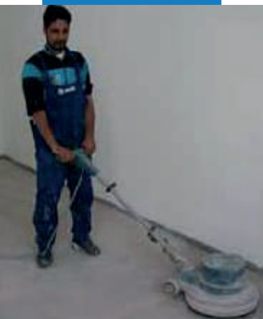
Brúsenie Ultraplan Eco po vytvrdnutí – škôlka pre deti - Mirabello – Cantu (Como) – Taliansko
