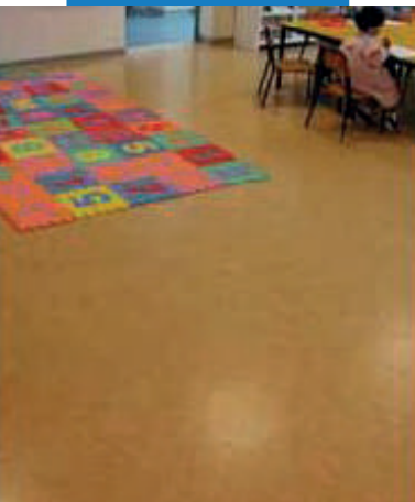
Linoleum inštalované na Ultraplan Eco, ktorý sa použil pri vyhladení cementového poteru
