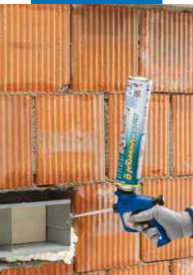
Výplň ventilačného otvoru
