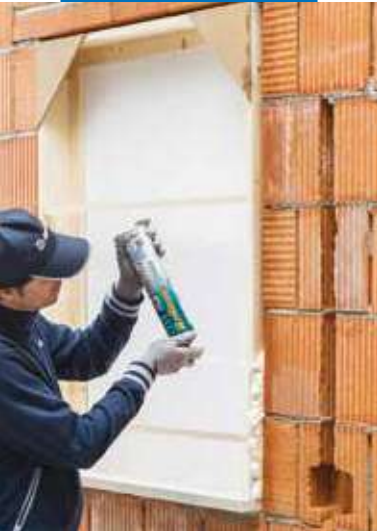
Výplň dutiny medzi okenným rámom a stenou
