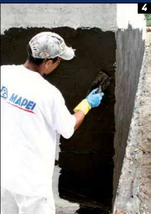
4. Hydroizolácia nadzákladového muriva
