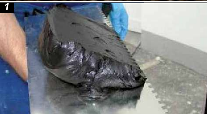
1/2. Hydroizolácia s použitím výrobku Plastimul
