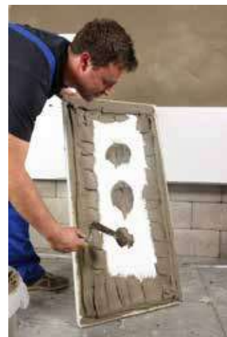
Nanosenie lepidla po obvode a bodovo v strede dosky.
