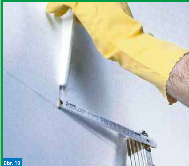
Vloženie izolačného materiálu do škáry širšej ako 2 mm.
