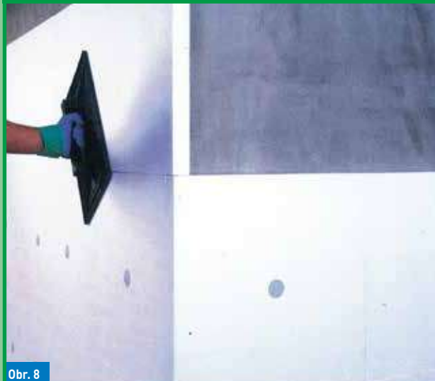
Prebrúsenie tepelnoizolačného panela (len pri EPS).
