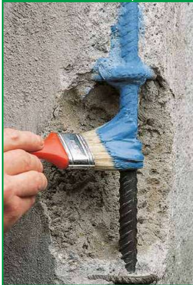
Ochrana oceľovej výstuže použitím antikorózneho náteru Mapefer.
