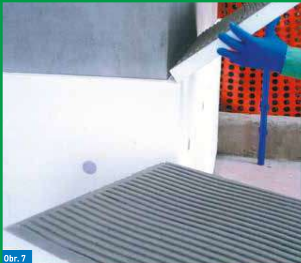
Montáž izolačných dosiek s riešením spojov v rohoch.
