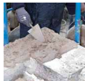
Rekonštrukčné práce na murive
