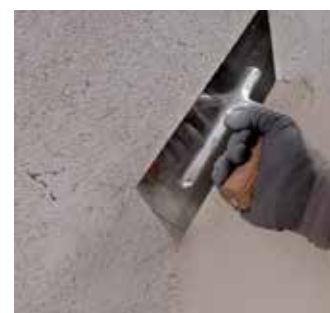
Aplikácia hrubej vyhladzovacej malty
