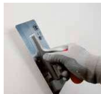
Konečné vyhladenie povrchu kovovou stierkou
