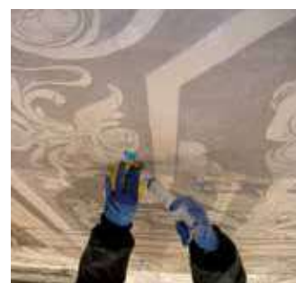
Obnovenie prídržnosti pôvodnej dekoračnej omietky
