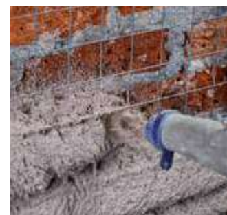
Aplikácia konštrukčnej omietky omietacím zariadením
