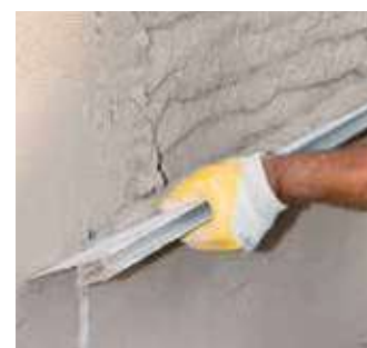
Zarovnanie nanesej paropriepustnej omietky latou
