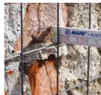
Kontrola krytia výstuže
