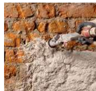
Aplikácia základnej vrstvy omietacím zariadením
