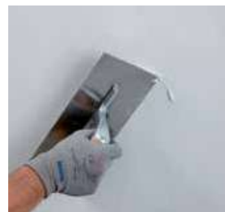
Aplikácia druhej vrstvy veľmi jemnej vyhladzovacej malty
