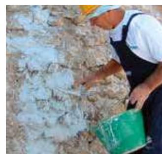
Aplikácia základnej vrstvy murárskou lyžicou
