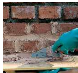
Výplň škár vzniknutých v tehlovom murive
