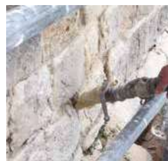
Spevnenie suchého kamenného muriva
