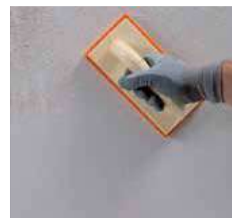
Konečné vyhladenie povrchu hubkou
