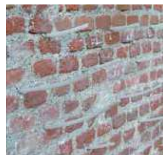
Spevnenie tehlového muriva
