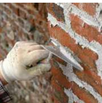
Výplň škár vzniknutých v tehlovom murive
