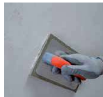
Konečné vyhladenie povrchu hubkou
