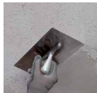
Aplikácia jemnej vyhladzovacej malty
