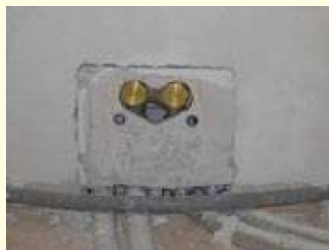
Príklad: Pripojenie pomocou HERZ podomietkového rozdeľovača HERZ SwitchFix 1 3030 01
