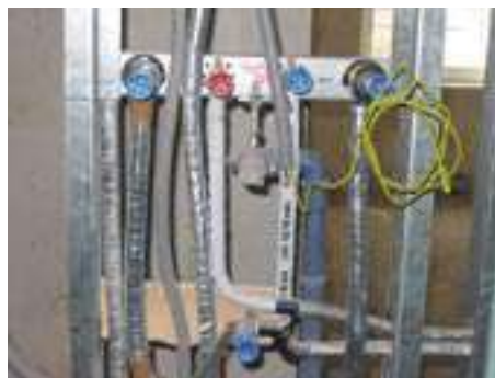
Príklad: Inštalácia rozvodov pitnej vody medzi dve steny s HERZ rúrami
