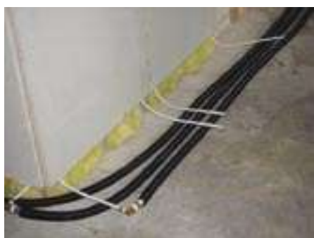
Pripojenie stenového vykurovania
