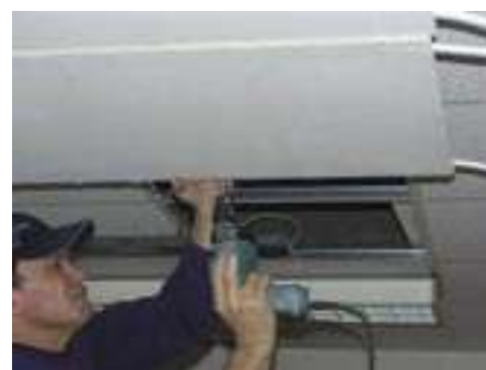
Montáž chladiaceho panelu
