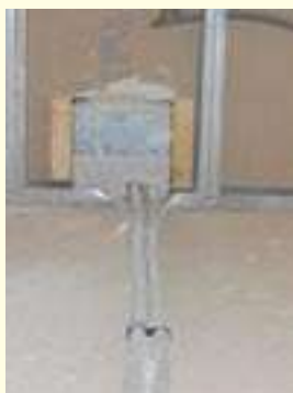
Príklad: Pripojenie pomocou HERZ podomietkového rozdeľovača HERZ SwitchFix 1 3030 01
