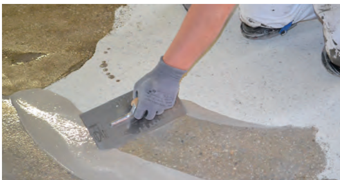
Detail povrchu po aplikácii vyrovnávacej stierky
