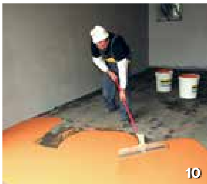
Ozubenou stierkou živicu rovnomerne roznesť po ploche a postupne dolievajte ďalšiu hmotu.
