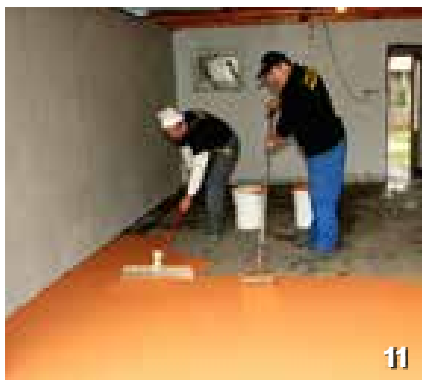
Ľneď po roznesení hmoty na podklad ju odvzdušnite odvzdušňovacím valcom. Odstránia sa tak vzduchové bubliny, ktoré vznikli pri miešaní živice.
